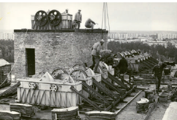
Испытания 5-этажного фрагмента серии И-163.04 и 10-этажной блок-секции серии И-163.02 в г. Ангарске, 1992 г.
