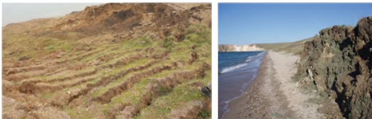
Рисунок 3.17. Трещины отпора и оползневые массы, поступающие на пляж.
