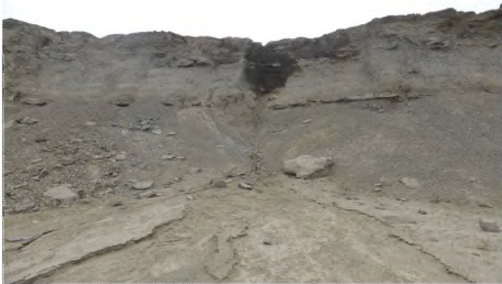
Рисунок 4.15. Эрозионная форма и крупный конус выноса, северный борт карьера на +220-м горизонте.
