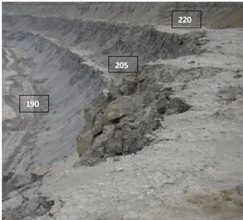
Рисунок 4.11. Панорамный снимок уступов +220, +205 и +190-го горизонтов с нависающими блоками горной породы на бровке +220-го горизонта (фото 2013 г.).
