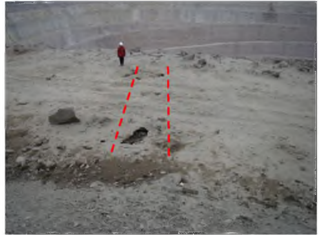
Рисунок 4.8. Просадка ( А ); трещины вдоль борта карьера ( Б ); провал ( В ); зона просадок вкрест простирания уступа +220-ого горизонта ( Г ).
