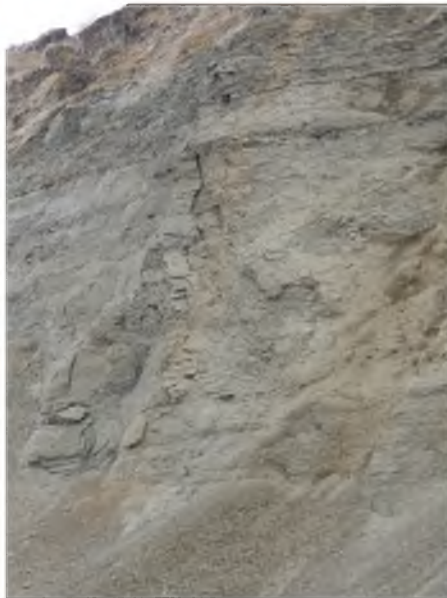
Рисунок 4.9. Вертикальная трещина на поверхности откоса ( А ); хорошо выраженная зона трещиноватости горных пород в откосе ( Б ) +220-й горизонт.
