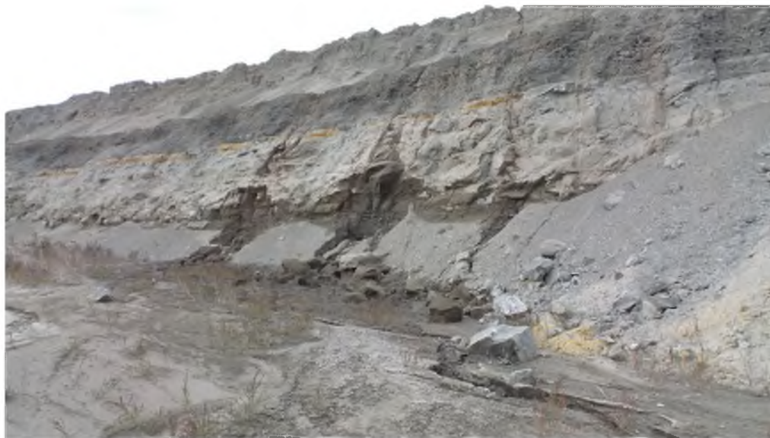
Рисунок 4.31. Эрозионные формы в местах разгрузки подземных вод на +190-м горизонте.
