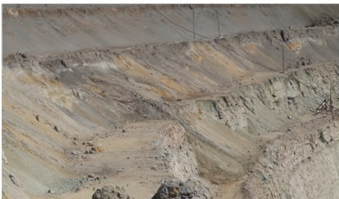
Рисунок 4.16. Оползень, захвативший +190, +175-й горизонты, перекрыл берму +160-го горизонта (фото 2018 г.).
