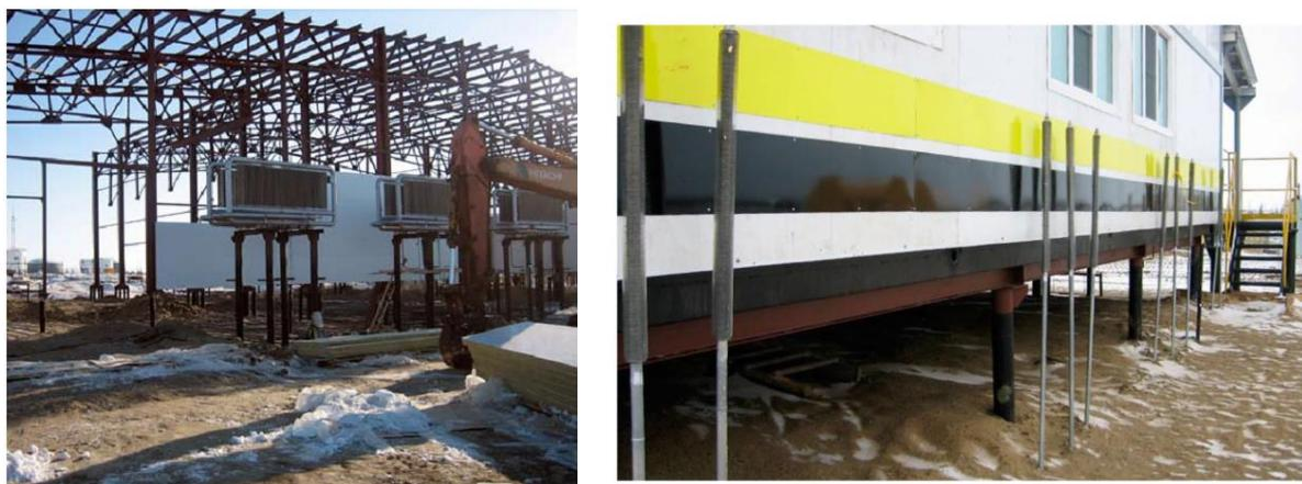
*Рис. 3.21. Устройство термостабилизаторов на месторождении [9]*
