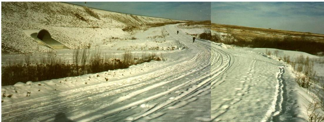
**Рис. 5.11. Наледь на руч. Чичон после восстановления грунтового объезда формируется в основном перед ним (фото из архива ТранСИГЭМ)**
