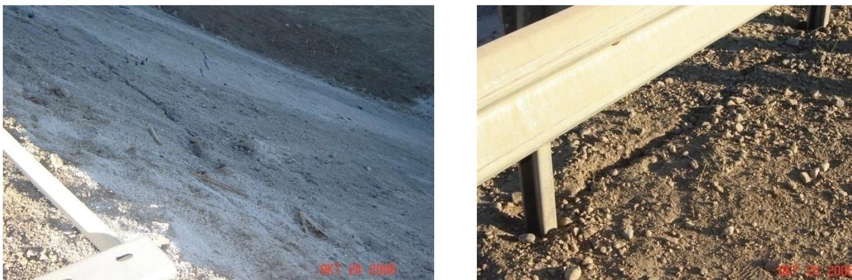
**Рис. 5.16.** Трещины на откосе и бровке насыпи на участке автодороги «Амур», км 247, на 24.10.2006 г. (фото из архива ТранСИГЭМ)
