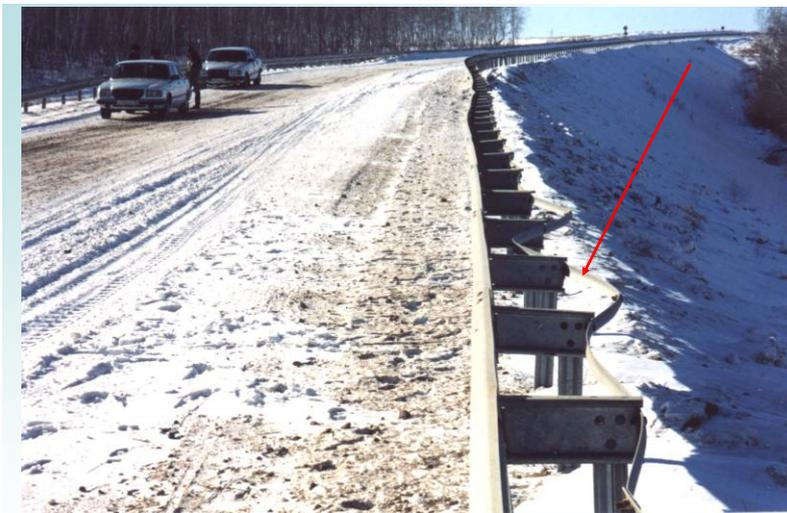
**Рис. 5.9.** Деформации северного металлического ограждения автодороги, км 247, 20.02.2002 г. (фото из архива ТранСИГЭМ)
