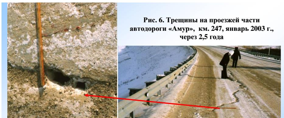
**Рис. 6. Трещины на проезжей части автодороги «Амур», км. 247, январь 2003 г., через 2,5 года**
