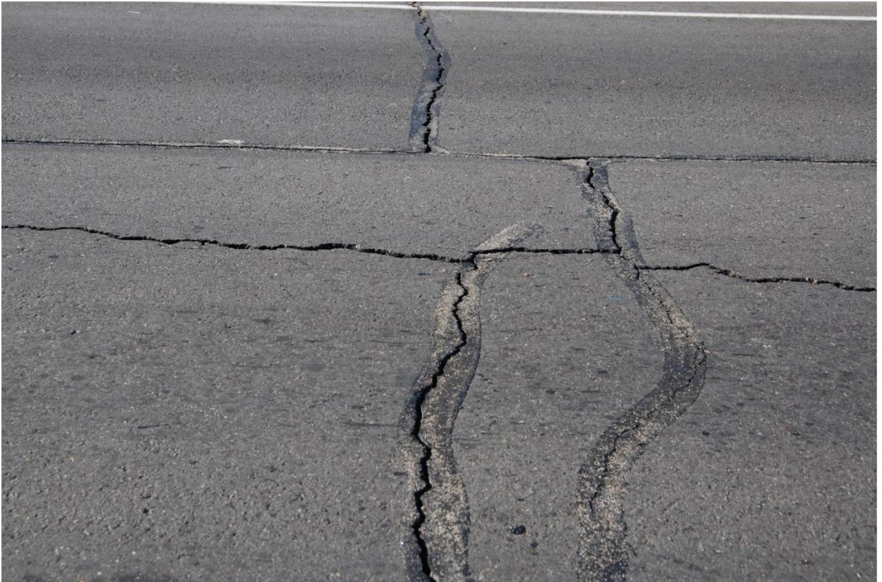
**Рис. 3.9. Морозобойные трещины асфальтового покрытия автодороги «Амур»**
