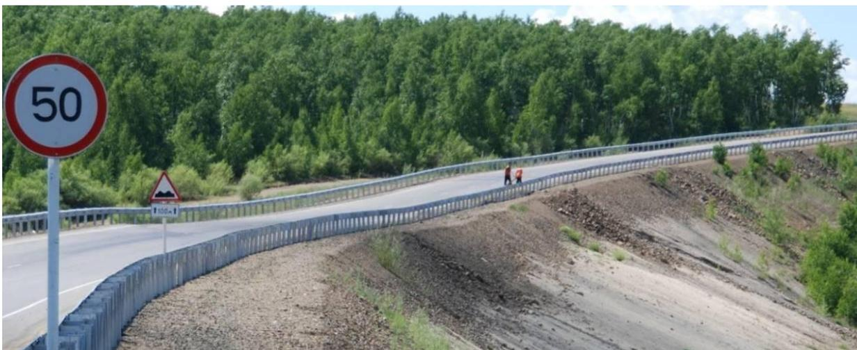
**Рис. 5.24.** Состояние участка автодороги «Амур», км 247, на 20.07.2010 г., через 9 месяцев после второго ремонта и асфальтирования на завершающей стадии её строительства (фото из архива ТранСИГЭМ)
