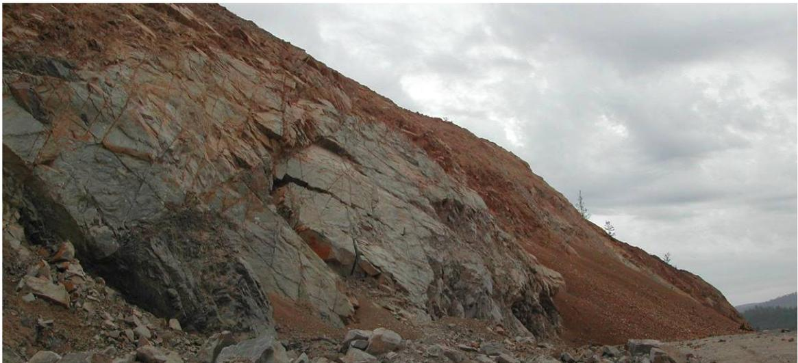
**Рис. 3.5. Состояние левого, южной экспозиции, откоса выемки 390 км автодороги «Амур» на 8 августа 2003 г., через 4 месяца после вскрытия**
