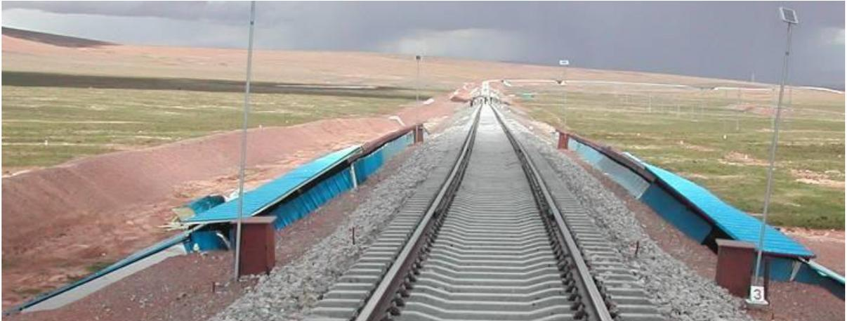
Рис. 4.12. Солнцезащитные навесы на откосах насыпи Цинхай-Тибетской ж.д. на участке льдистых грунтов в основании (фото из архива ТрансИГЭМ, август 2006 г.)
