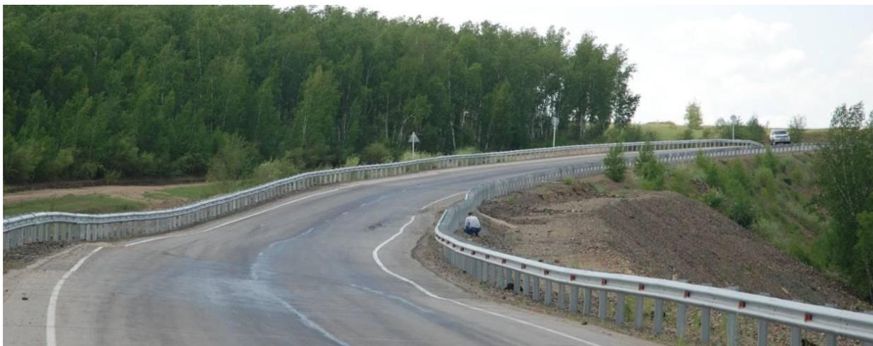
**Рис. 5.29.** Состояние участка автодороги «Амур», км 247, на 20.07.2011 г., через 11 месяцев после третьего ремонта (фото из архива ТранСИГЭМ)
