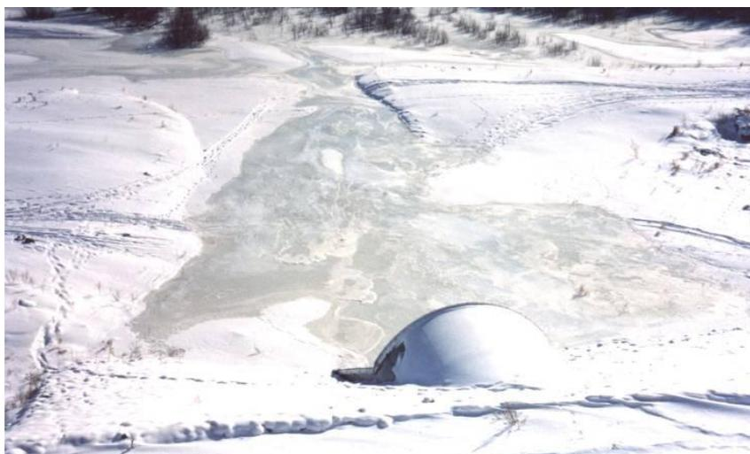
**Рис. 5.10.** Наледь на руч. Чичон до восстановления грунтового объезда, 20.02.2002 г. (фото из архива ТранСИГЭМ)
