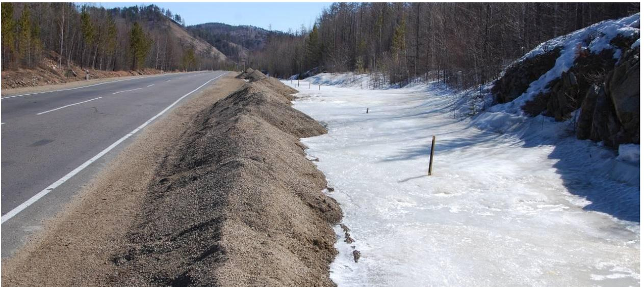
**Рис. 3.3.** Выход наледи трещинно-жильных вод на 66 км автодороги «Амур»
