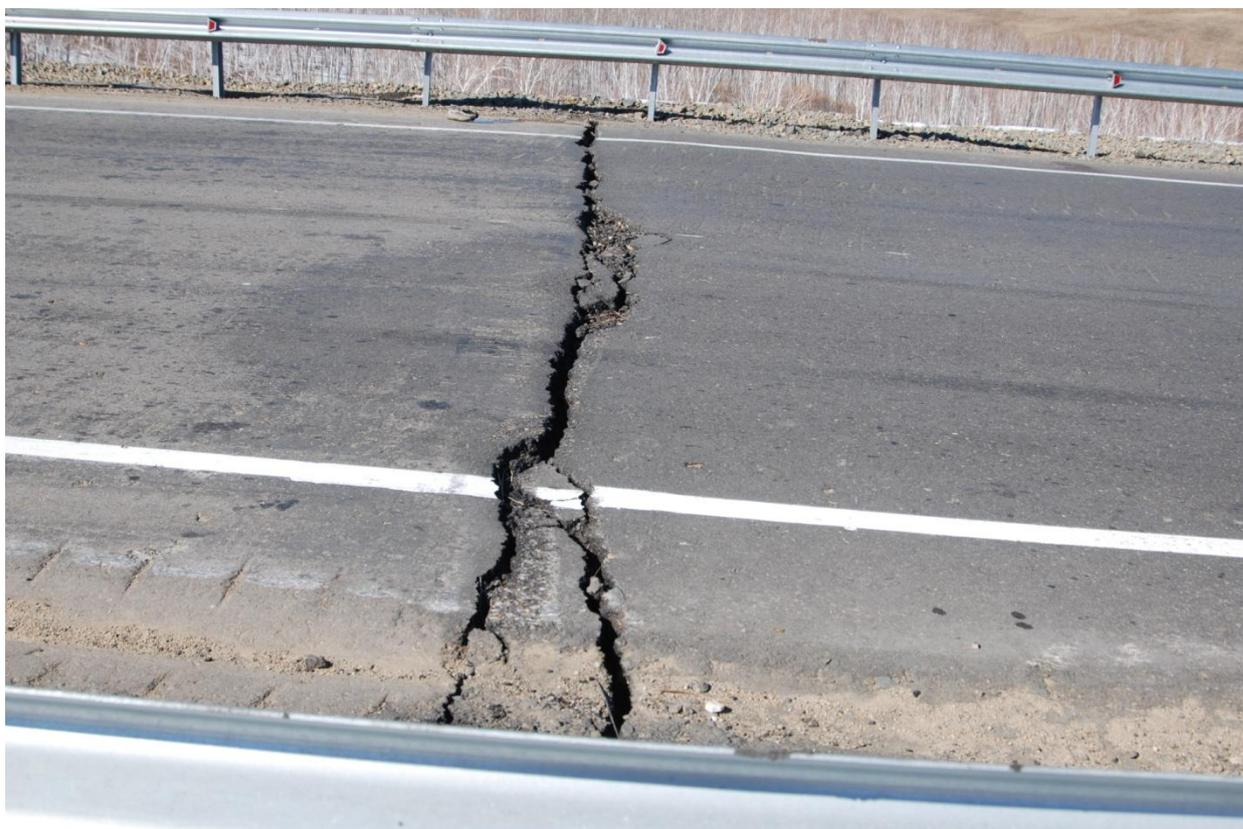
**Рис. 5.28.** Поперечные трещины на участке автодороги «Амур», км 247, 1.04.2011 г. (фото из архива ТранСИГЭМ)
