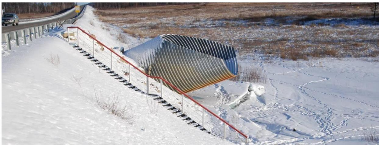
**Рис. 4.2. Деформированная труба на 526 км автодороги «Амур», 25.12.2012 г. (фото из архива ТранСИГЭМ, 25 декабря 2012 г.)**
