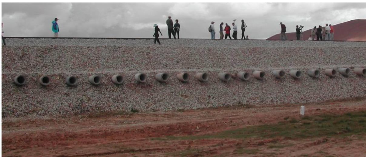
**Рис. 4.35.** Поперечные вентилируемые железобетонные трубы в основании земляного полотна Цинхай-Тибетской жд. на участках льдистых грунтов (фото из архива ТранСИГЭМ)
