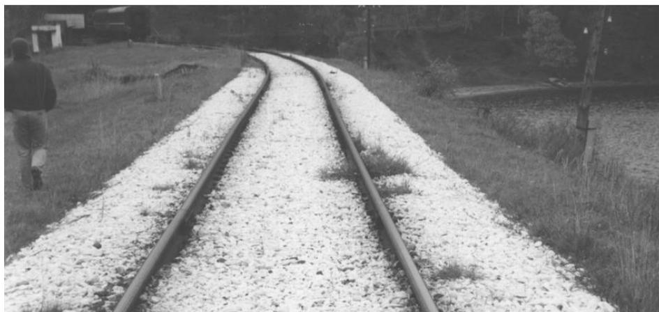
**Рис. 4.4. Участок Кругобайкальской железной дороги с белым мраморным балластом из Слюдянского месторождения**
