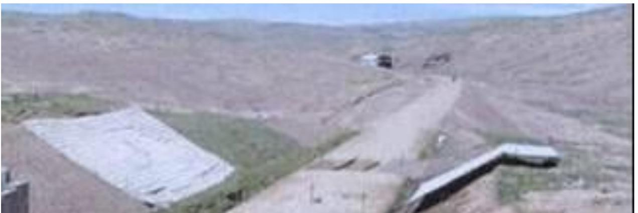
**Рис. 4.9.** Навес над северо-западным откосом выемки на экспериментальном полигоне СЗФ АН МЖД КНР на склоне г. Фэнхо, Тибет, июль 2000. Фото Чжан Лусина
