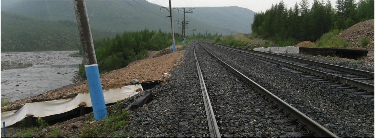
**Рис. 4.20 . Экспериментальный солнцезащитный навес на Центральном участке БАМ, 1841 км (фото из архива ТрансИГЭМ, июль 2012 г.)**
