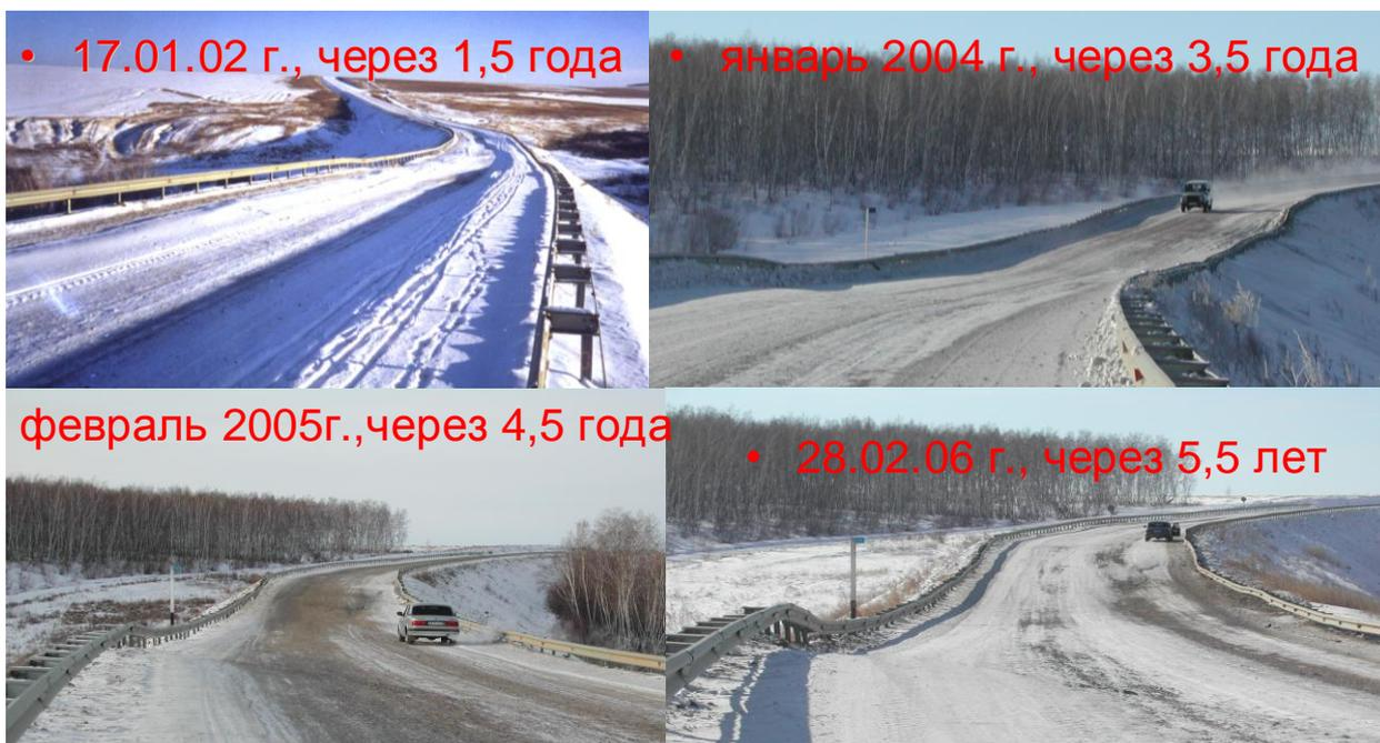
Рис. 5.3. Состояние автодороги «Амур», км 247, на разные даты в 2002-2006 гг. (фото из архива ТранСИГЭМ)
