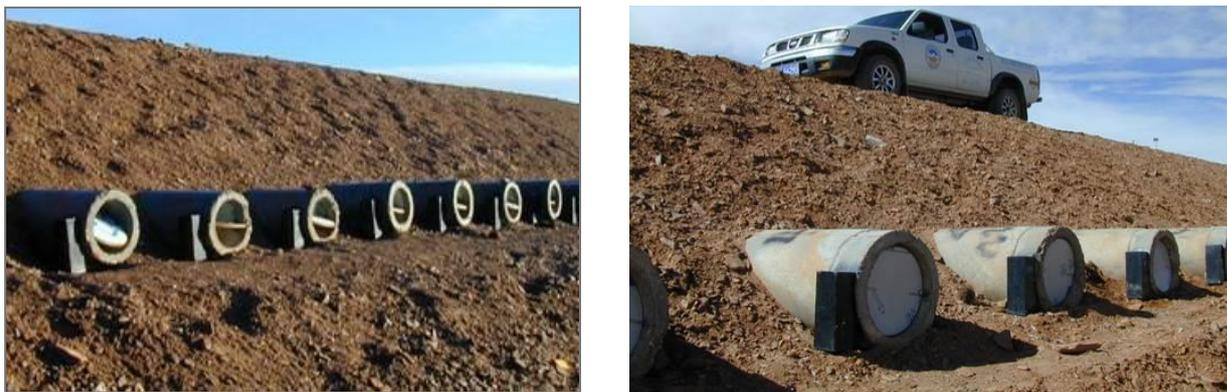
**Рис. 4.34.** Поперечные вентилируемые железобетонные трубы в основании земляного полотна Цинхай-Тибетской жд. с автоматическими закрывашками (фото из архива ТранСИГЭМ)
