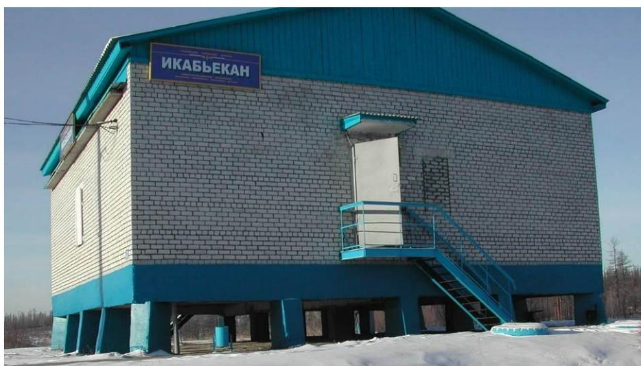
**Рис. 4.7. Службное здание с проветриваемым подпольем на ст. Икабьекан Восточно-Сибирской ж.д. (фото из архива ТрансИГЭМ)**
