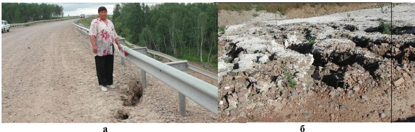
**Рис. 5.22. Трещины (а) и промоины (б) на участке автодороги «Амур», км 247 на 7.07.2007 г. (а) и на 11.08.2007 г. (б) (фото из архива ТрансИГЭМ)**
