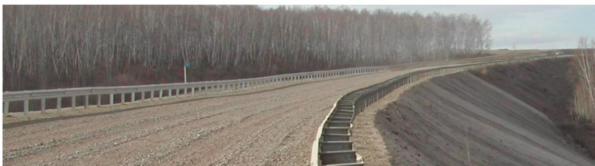
**Рис. 5.14.** Состояние отремонтированного участка автодороги «Амур», км 247, на 18.10.2006 г. (фото из архива ТранСИГЭМ)
