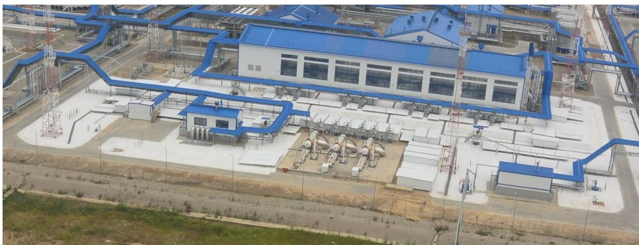
Рис. 4.25. Солнцезащитные навесы и белый щебень на противодиффузионной пленке на площадках технологических трубопроводов на НПС-14 МН ВСТО-1 (фото из архива Транснефть-Восток)
