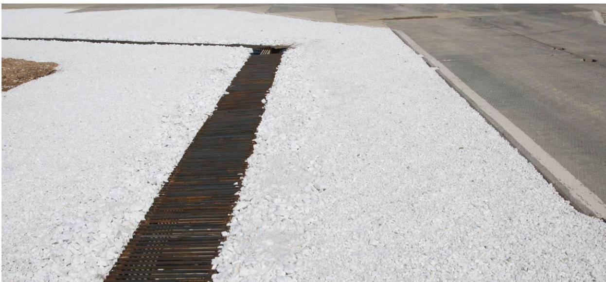
**Рис. 4.6. Дренажный лоток для отвода дождевых вод с площадки одной из нефтеперекачивающих станций магистрального нефтепровода ВСТО-1, август 2014 (фото из архива Транснефть-Восток, май 2015)**
