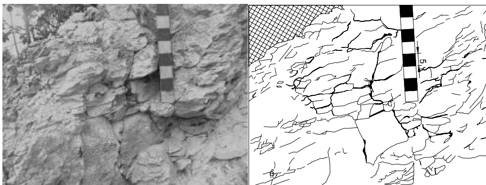
Рис. 3.18. Форма поверхности трещин в плане.
