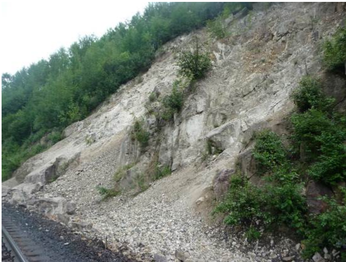
Рис. 3.15. Левый откос выемки по ходу километров.
