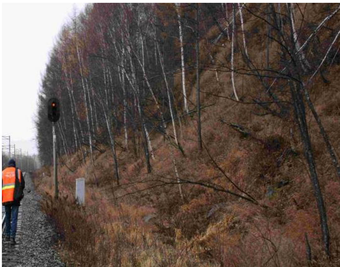
Рис. 3.29. Характерный фрагмент обвалоопасного участка (октябрь 2007 г.).
