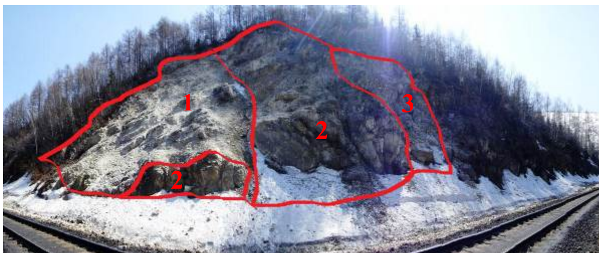
Рис. 3.19. Панорамный снимок левого откоса выемки с границами зон трещиноватости.
