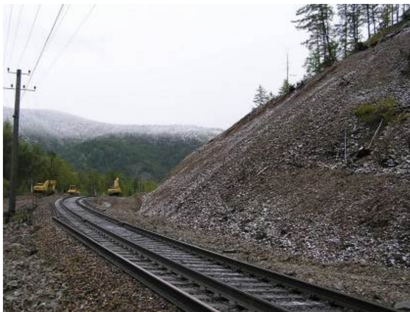
Рис. 3.31. Характерный фрагмент обвалоопасного участка, сентябрь 2010 г.
