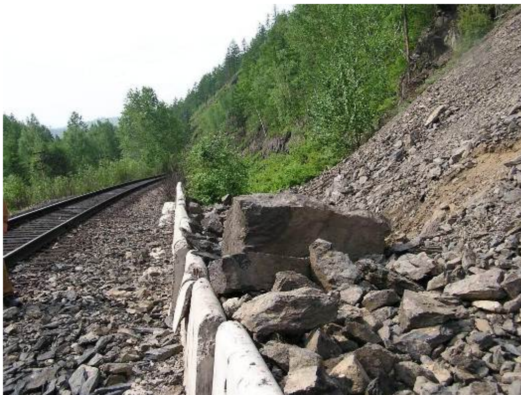
Рис. 3.23. Подпорная стенка, заполненная обвалившимися обломками разного диаметра.
