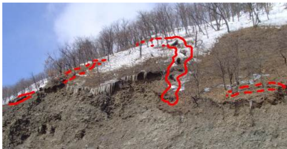
Рис. 3.6. Трещины по верху откоса (Фото автора).
