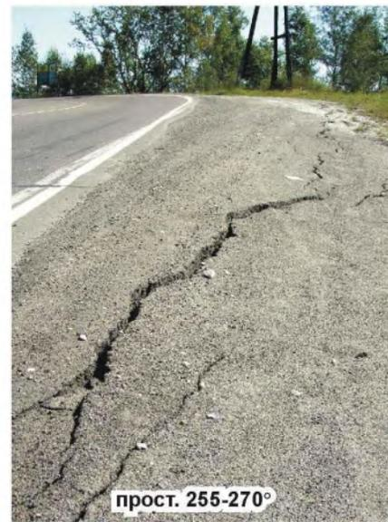
На протяжении 115 м - система трещин с простиранием 255-270°. Их раскрытие от 3 до 9 см, амплитуда сброса 4-5 см. По смещению бортов трещин улавливается левый сдвиг в первые см.
